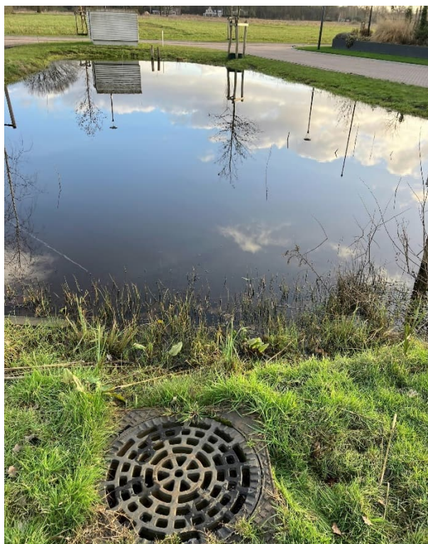
Afbeelding 15 Wadi in Vlakwater
