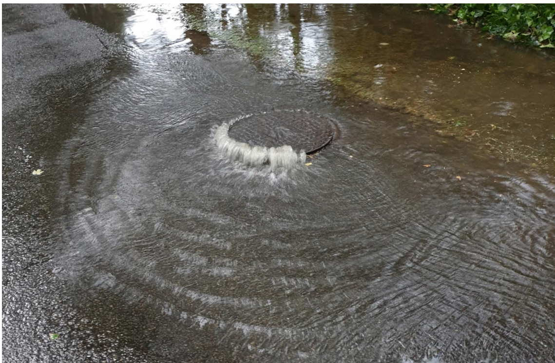
Afbeelding 12 Hemelwater dat uit de riolering stroomt ter hoogte van Kempweg
