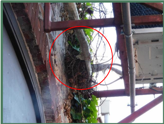
Foto 9: Duivennesten tegen oostzijde gebouw plangebied (Schoutenstraatje 20).
