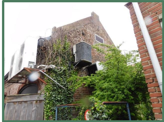
Foto 10: Zuidzijde gebouw (plangebied).
