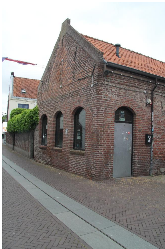
De ramen met segmentboog in de voorgevel en de deur in de zijgevel zijn recent aangebracht (XXd)
