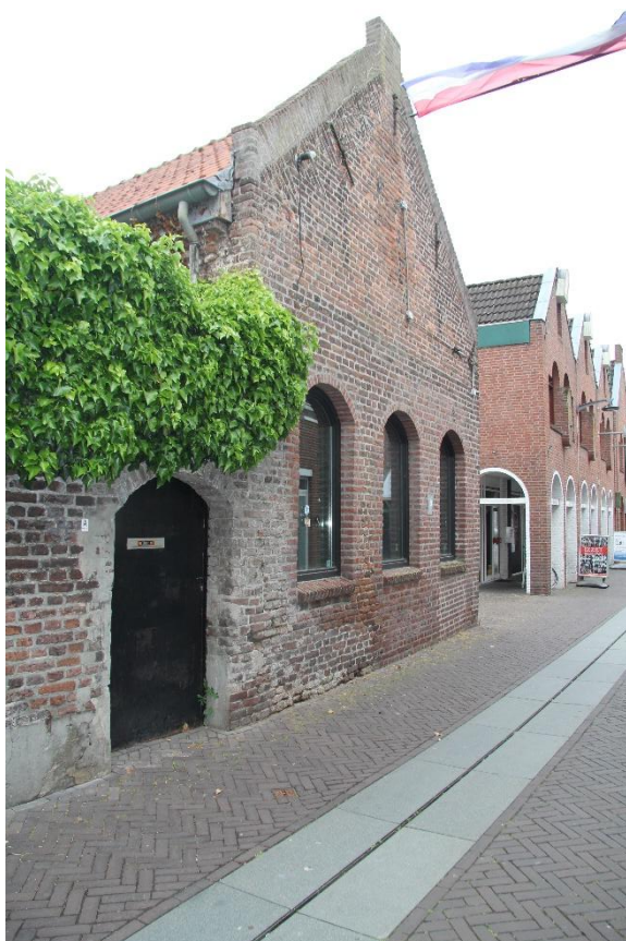
Het poortje rechts naast de topgevel is recent (XXd)
