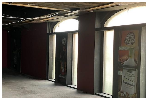
De voormalige poorten zijn op dit moment voorzien van een puivulling met een dichte deur met rondom glas
