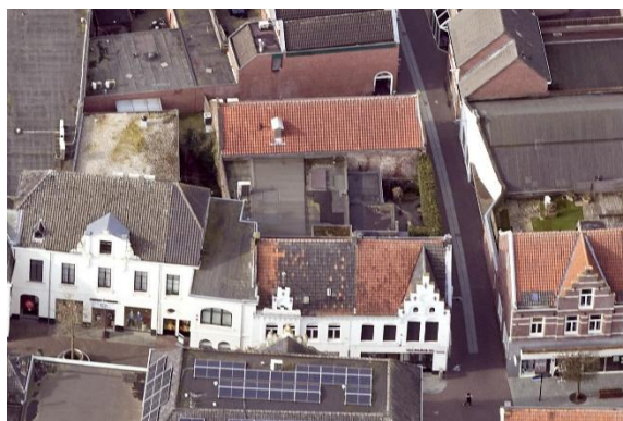
Luchtfoto van de huidige situatie, in westelijke richting
