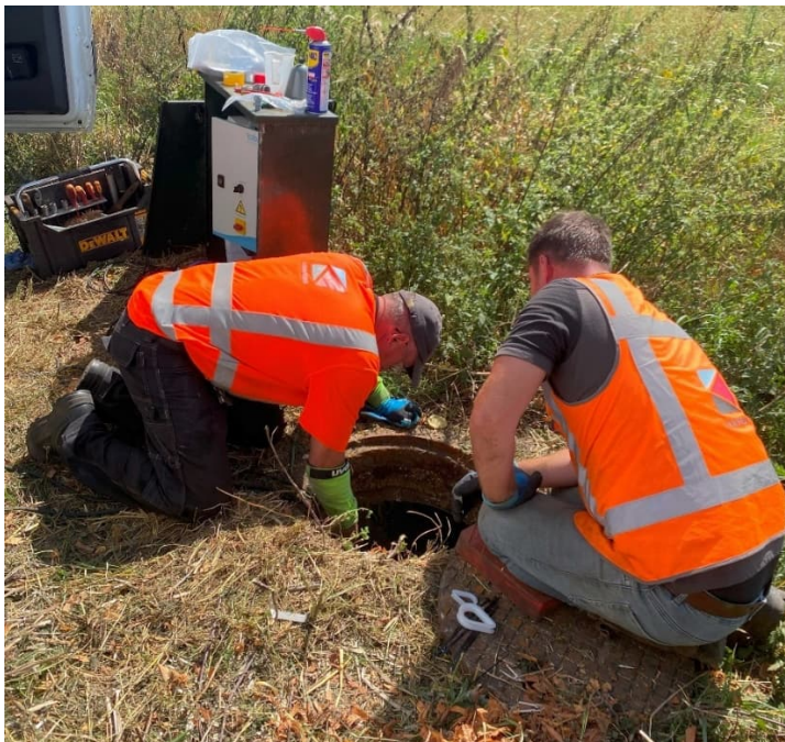
Afbeelding 9 Renovatie pompunits drukriolering
