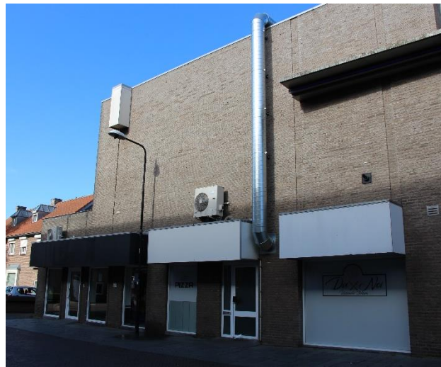
Afb 8: verwijderen storende gevelelementen
