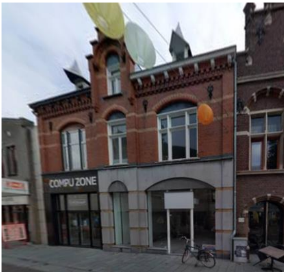
Afb 1 en 2: terugbrengen origineel en hoogkwalitatief natuurstenen gevelmateriaal
