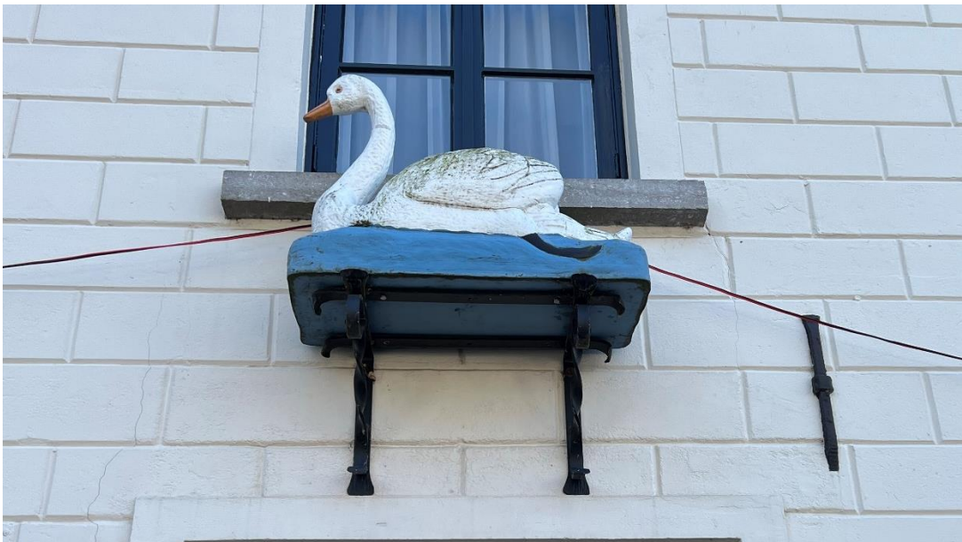
Afb 3: terugbrengen oorspronkelijke gevelelementen: renovatie en terugplaatsing de Zwaan
