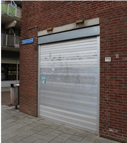
Afb 7: verwijderen rolluiken op de begane grond
