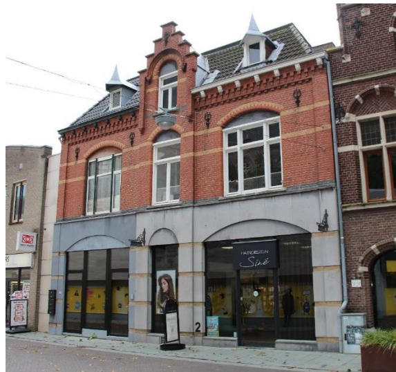
Afb 1 en 2: terugbrengen origineel en hoogkwalitatief natuurstenen gevelmateriaal
