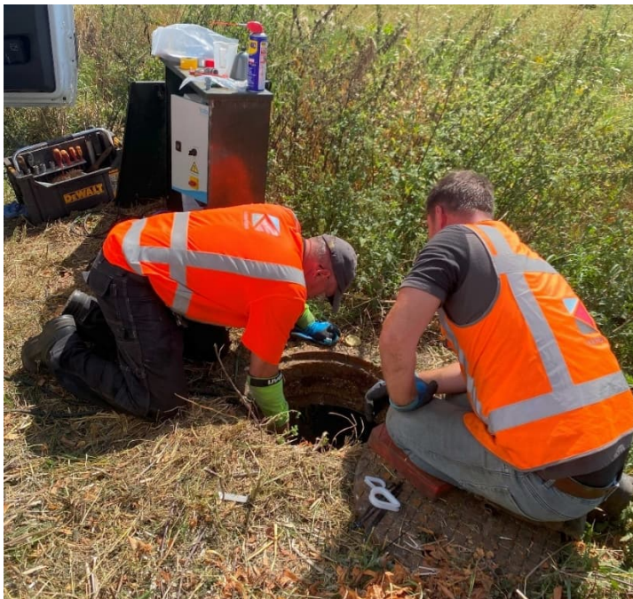
Afbeelding 9 Renovatie pompunits drukriolering
