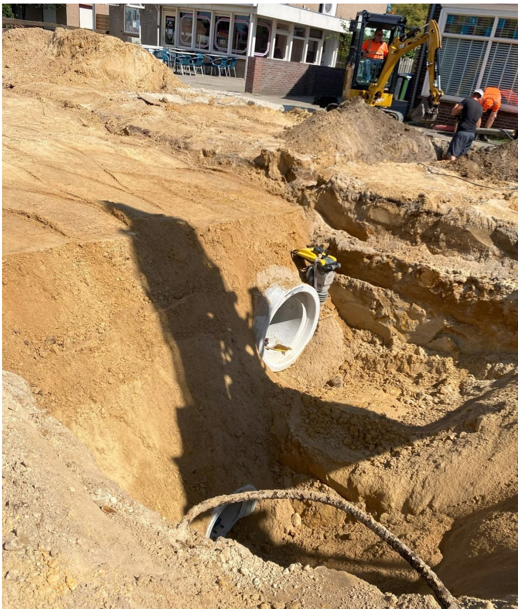
Afbeelding 3 Riolvervanging en aanleg infiltratieriolering Albionstraat Leunen
