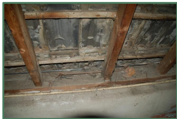
Open dak boven goot bedrijfsgebouwe
