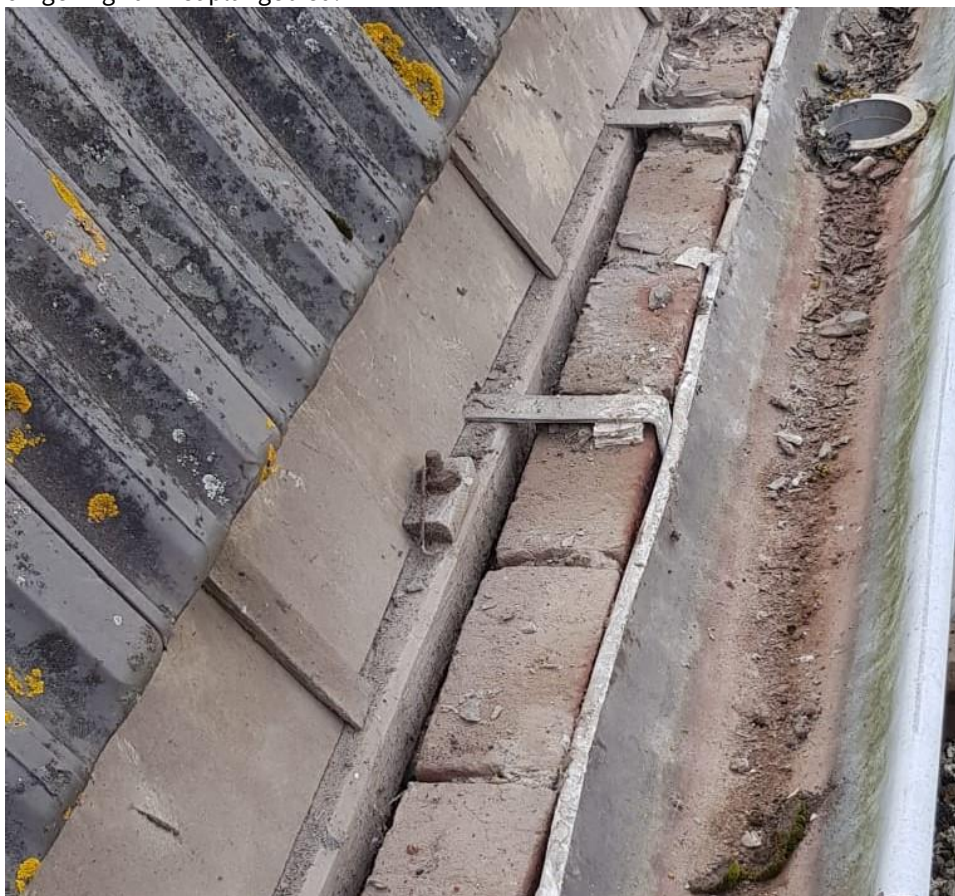
Controle onderste rij pannendak
