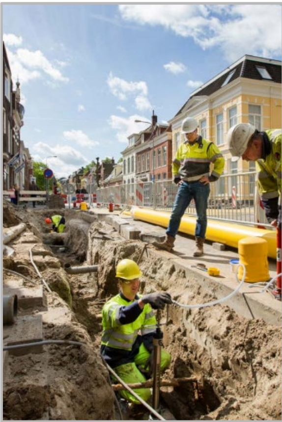
Figuur 3.5: Elektriciteitsnet werkzaamheden in de straat. 6
